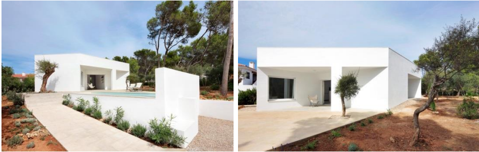
Şekil 9. 4 Porches and 4 Skylights Konutu’na Ait Ters Huni Etkisi ve Cephe Görselleri (URL-18, 2017; URL-19, 2017)
