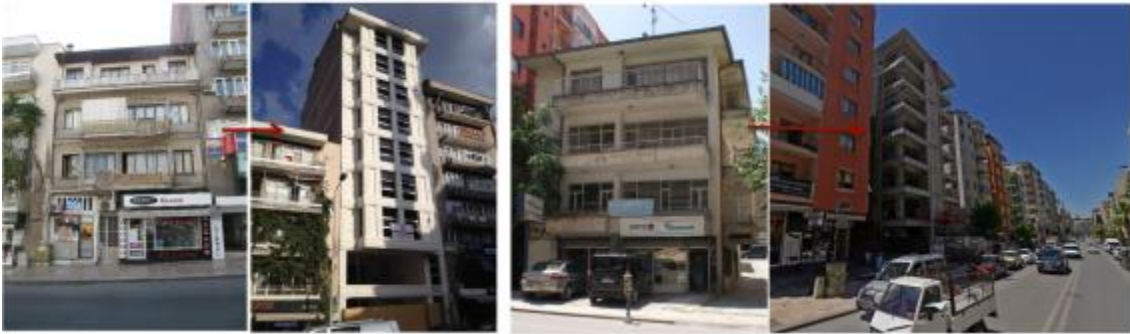
Şekil 16. Kent merkezindeki yıkılan apartmanlar (Avsan, 2015).
