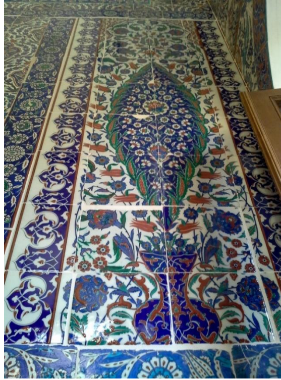
Resim10-Panonun restorasyonu tamamlanmış hali
