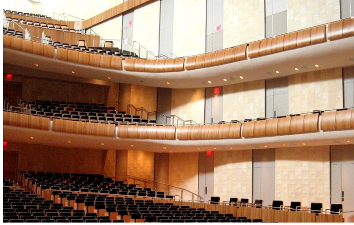
Şekil 12. Ses dağıtıcı yüzeyler; a. Musikvereinsaal Küçük Konser Salonu tavan yüzeyi (Mustafa KAVRAZ Arşivi), b. Peter Kiewit Konser Salonu duvar yüzeylerinde uygulanan ses dağıtıcılar
