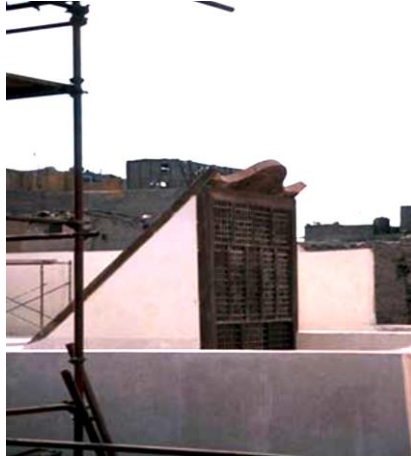
Şekil 3. Mısır'da uygulanan rüzgar kuleleri (malqaf) (Fathy, 1986 ; Pirhayati ve diğ., 2013)
