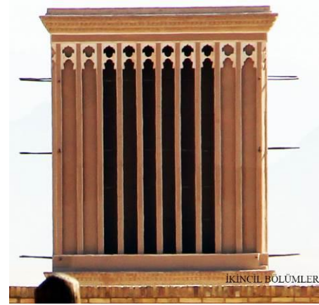
Şekil 5. Geleneksel rüzgar kulelerinde ayrı şaftlar oluşturan bölümler (Khatami, 2009), (Mustafa KAVRAZ Arşivi)
