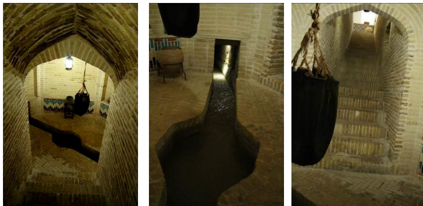
Şekil 10. Qanat sistemiyle kentteki yapılara getirilen suyun dağıtım şeması (Bharne ve Bogosian, 2010) ile bir otel binasında kanatlar vasıtasıyla gelen su ve suya ulaşım (Mustafa KAVRAZ Arşivi)
