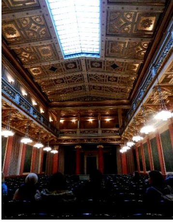
Şekil 12. Ses dağıtıcı yüzeyler; a. Musikvereinsaal Küçük Konser Salonu tavan yüzeyi (Mustafa KAVRAZ Arşivi), b. Peter Kiewit Konser Salonu duvar yüzeylerinde uygulanan ses dağıtıcılar
