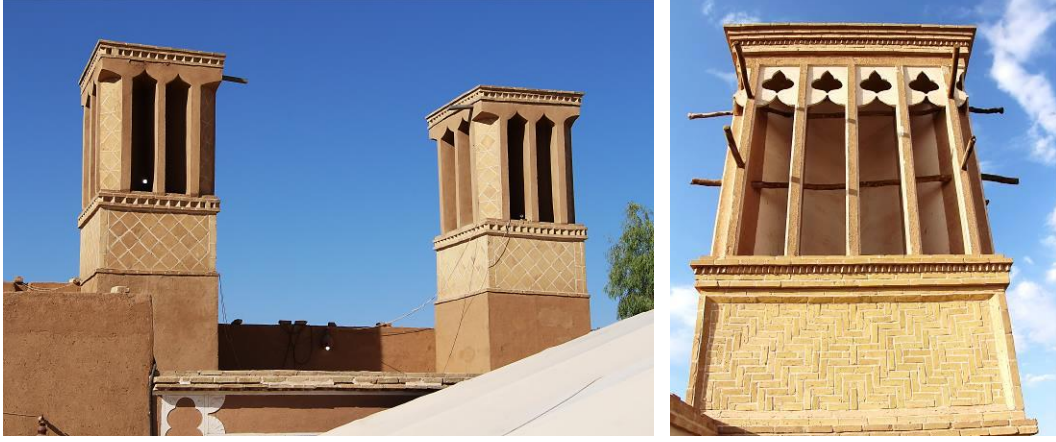
Şekil 15. Dekoratif yığma taşıyıcı rüzgar kule elemanları (Mustafa KAVRAZ Arşivi)
