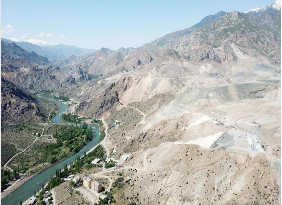
Fotoğraf 3. Yusufeli Yansıtıcılar Mevkii'nde sürdürülen alt yapı çalışmaları (2018).
