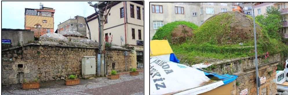
Fotoğraf 11. Eski Hamamdan Görünüm Fotoğraf 12. Çifte Hamamdan Görünüm
