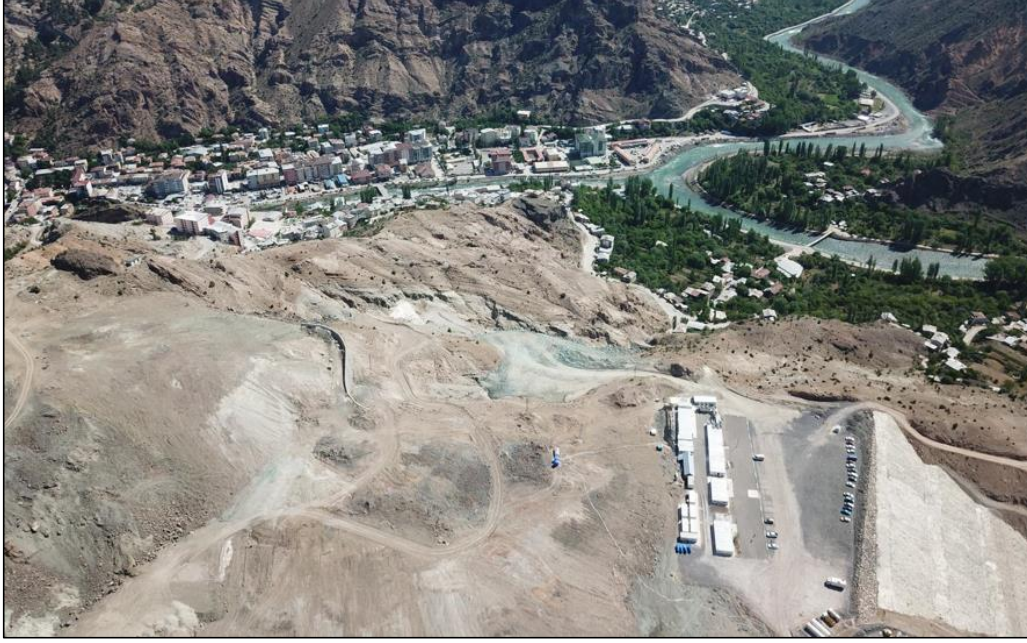
Fotoğraf 2. Yusufeli Yansıtıcılar Mevkii'nde sürdürülen alt yapı çalışmaları (2018).
